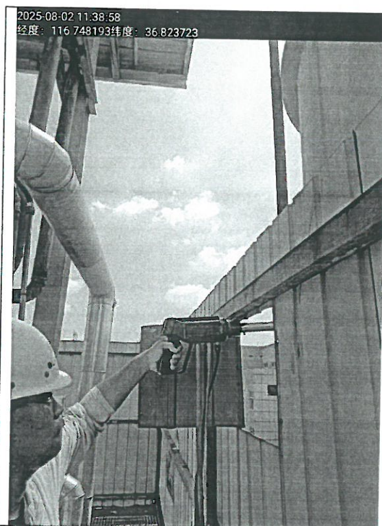
附图 1: 3#燃气轮机组处理设施后废气采样
