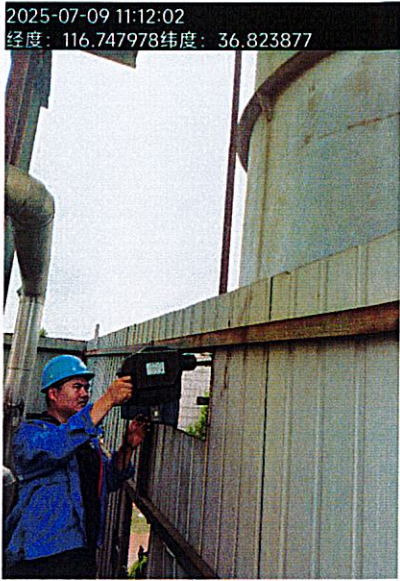
3#燃气轮机组排气筒 (DA018)
