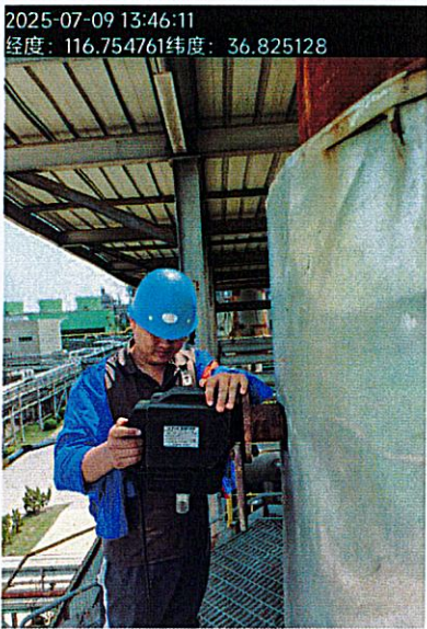
4#燃气轮机组排气筒 (DA019)
